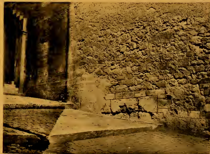
Mur Grec des Accoules
