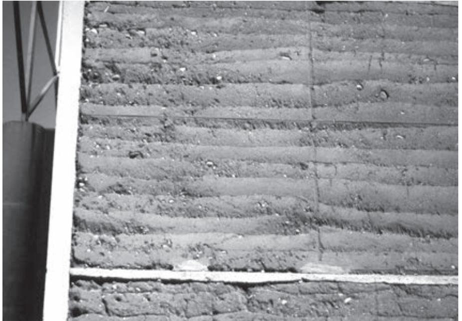
Fig.3 : Détail d'une construction en pisé contemporaine à l'Isle d'Abeau (Isère). Il s'agit d'un bâtiment public, bâti dans le cadre d'un projet expérimental piloté par le CRATerre. Noter la correction granulométrique apportée à la finesse de la terre par l'ajout de cailloux et la régularité des lits de damage.
