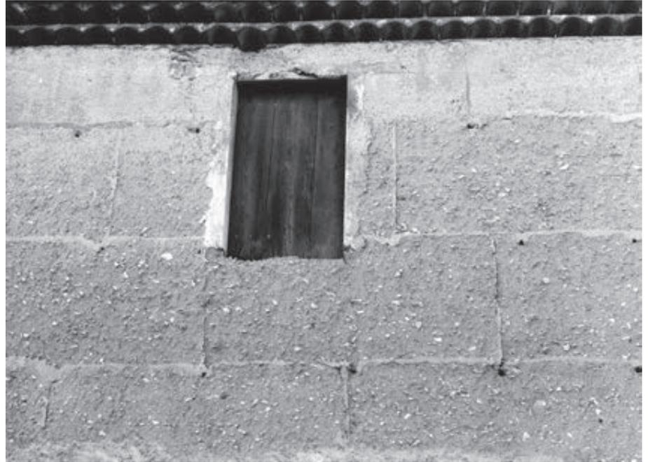
Fig.2 : Détail d'une façade en pisé construite au XIX<sup>e</sup> s. à Charleval (B.-du-Rh.). Noter l'abondance des cailloux au sein du matériau et leur orientation horizontale résultant du damage, les limites des banchées et les trous de clés horizontales.
